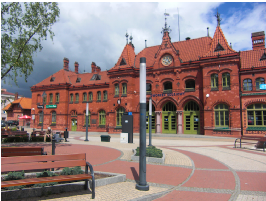
Zdjęcie 1. Dworzec kolejowy Malbork
