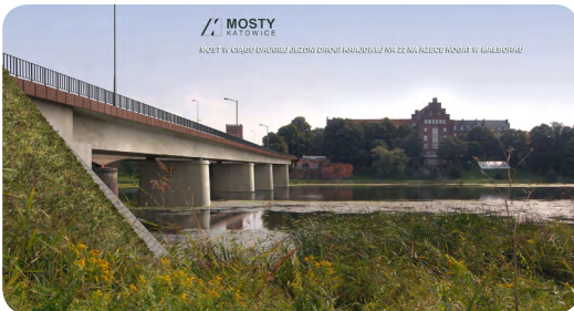
Foto: Mosty Katowice
